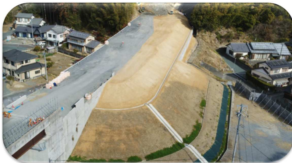
ICTを活用した工事の実施
